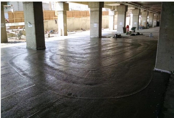
Avance de radier en edificio CDT
