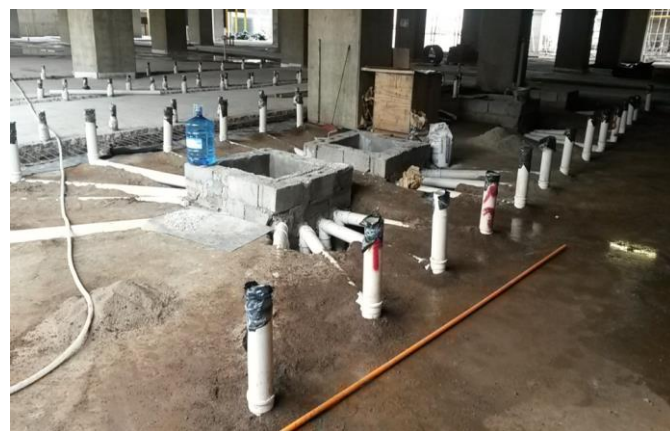
Ejecución de Alcantarillado enterrado en zona de vestidores TH
