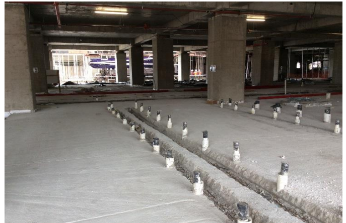
Hormigón de radier en edificio TH
