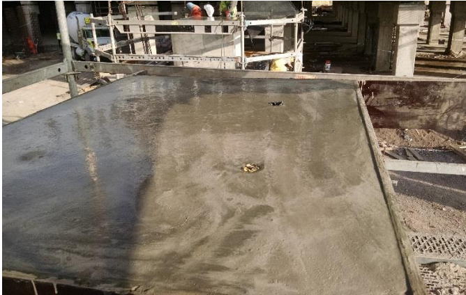
Grout en capiteles edificio CDT
