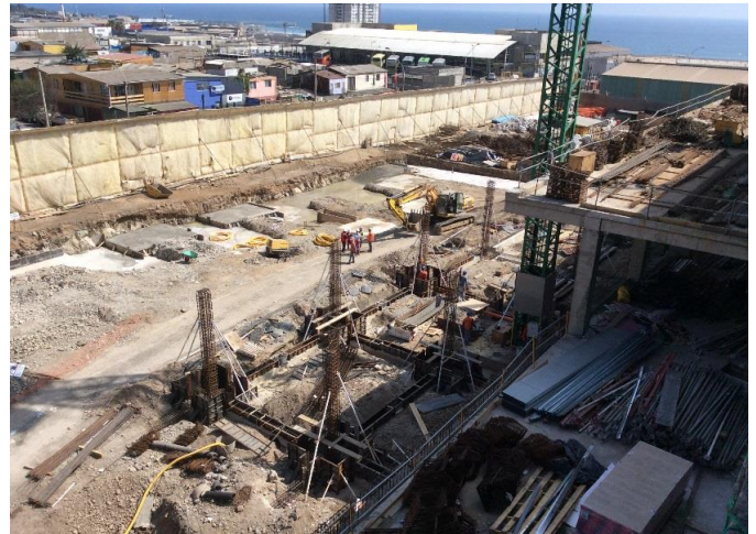
Control de enfierradura estacionamiento unidad de emergencia
