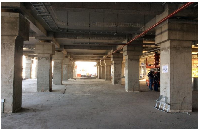
Grout en capiteles edificio CDT
